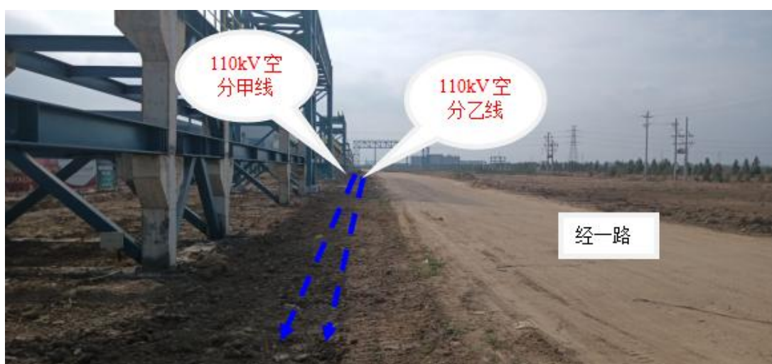
图 2-11 110kV 电缆经一路敷设情况一
