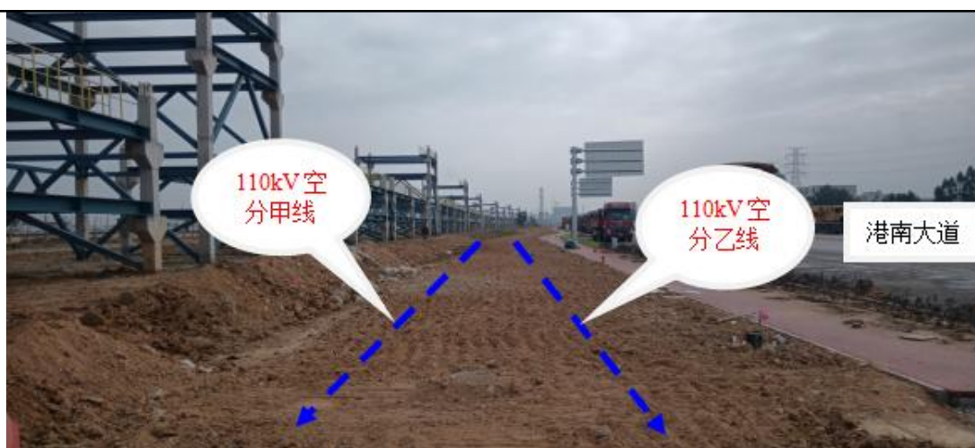
图 2-9 110kV 电缆沿港南大道敷设情况
